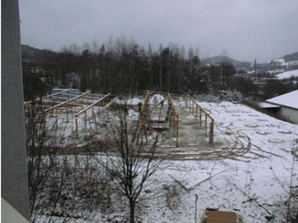
Abb. 17: Montage der Unterkonstruktion des zweiten Carports
