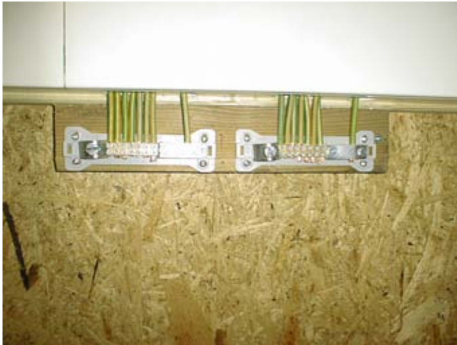
Abb. 13: Zwei weitere Sammelschienen, welche mit der Hauptpotenzialausgleichs-Schiene verbunden sind
