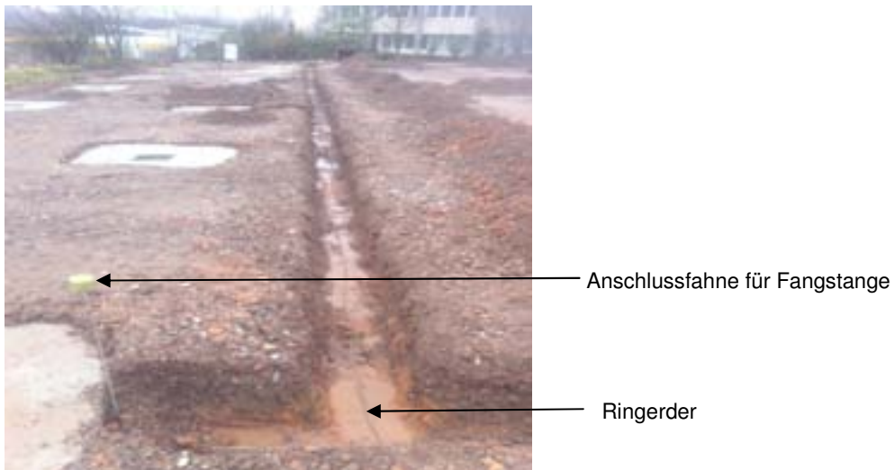
Abb. 9: Verlegung des Ringerders mit Anschlussfahnen für die Fangstangen
