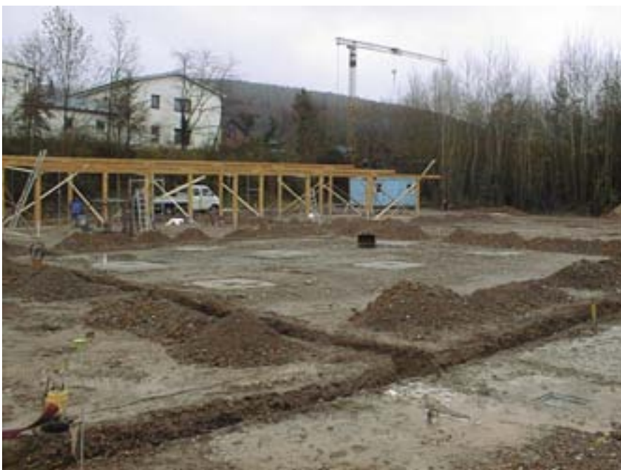
Abb. 16: Unterkonstruktion des ersten Carports aus Holz
