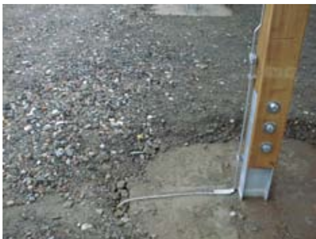
Abb. 10: Anschluss des Blitzableiter-Systems an den Ringerder
