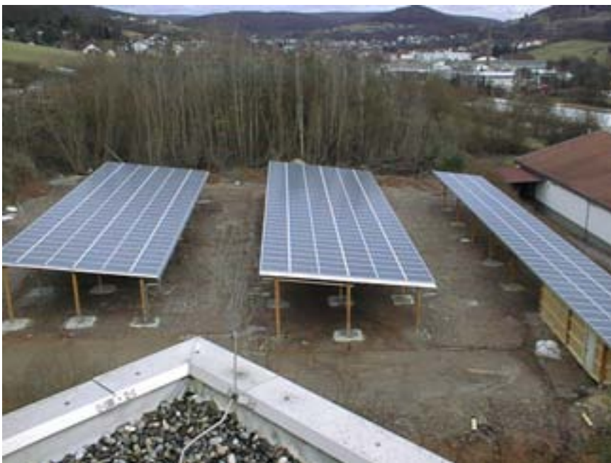
Abb.20: Fertig montierte und verkabelte Module
