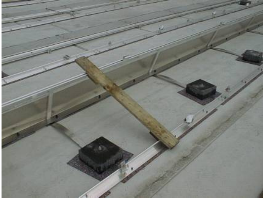
Abb. 3: Ballastarmes Flachdachmontagesystem während der Aufbauphase.
