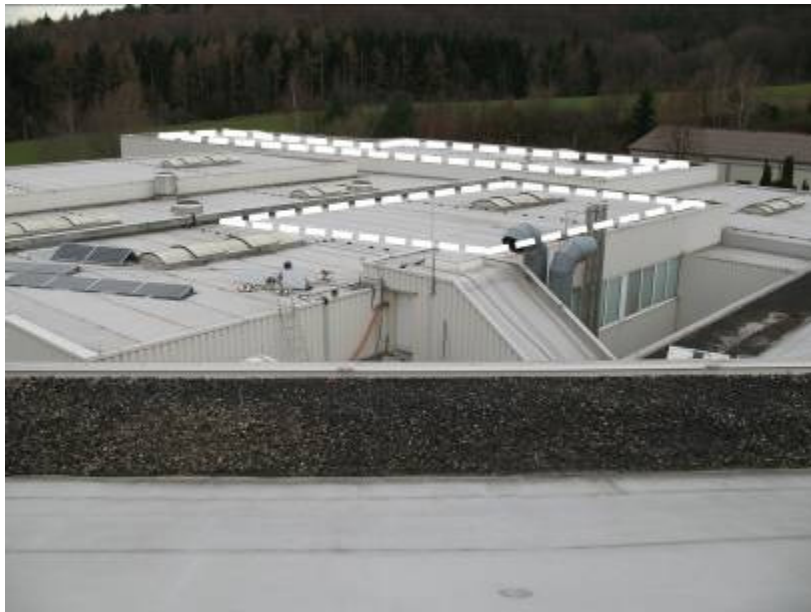
Abb. 1: Zur Verfügung stehende Fläche auf dem Flachdach (gekennzeichnet durch weiße Markierung)
