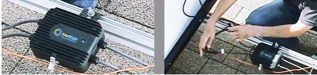
Abb. 9: Montage des SolarMagic (Werkfoto, Quelle: National Semiconductor)
