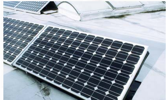
Abb. 6: Beispiel für reihenweise Verschattung. Hier sind die 4 unteren Reihen des Moduls verschattet. Da sich unmittelbar vor der Aufnahme eine Wolke vor die Sonne schob, ist die Verschattung nicht so deutlich zu erkennen, wie in Abb.5.
