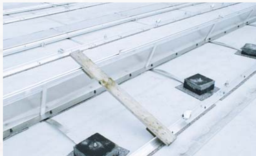
Abb. 3: Ballastarmes Flachdachmontagesystem während der Aufbauphase.
