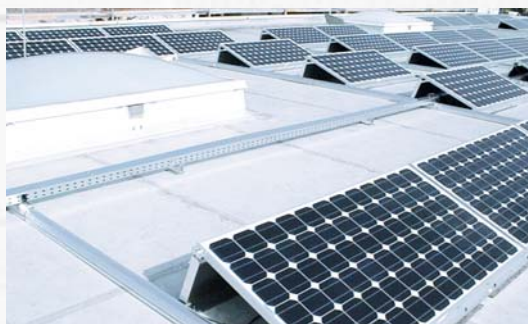
Abb. 4: Leitungsführung in Modulrahmen und metallinem Kabelkanal.
