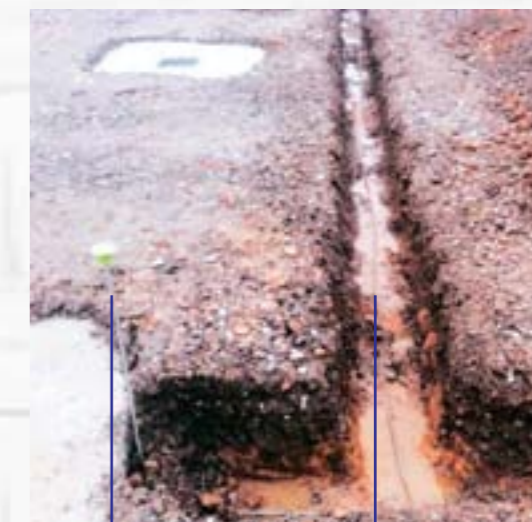
Anschlussfahne für Fangstange Ringerder
