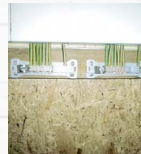
Abb. 22: Zwei weitere Sammelschienen, welche mit der Hauptpotenzialausgleichs-Schiene verbunden sind
