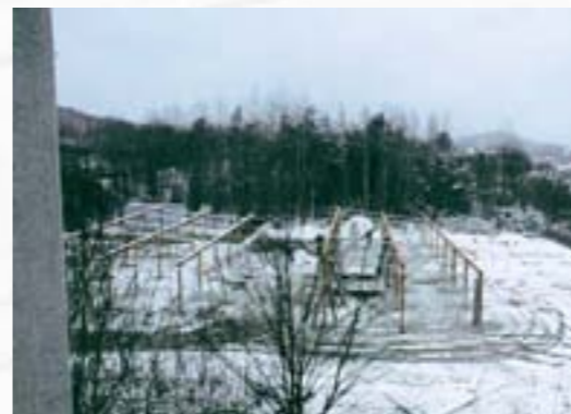
Abb. 3: Montage der Unterkonstruktion des zweiten Carports
