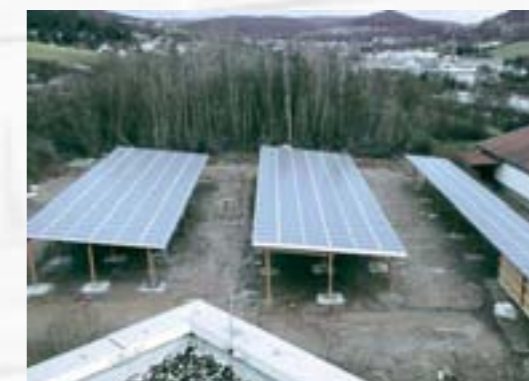
Abb. 6: Fertig montierte und verkabelte Module
