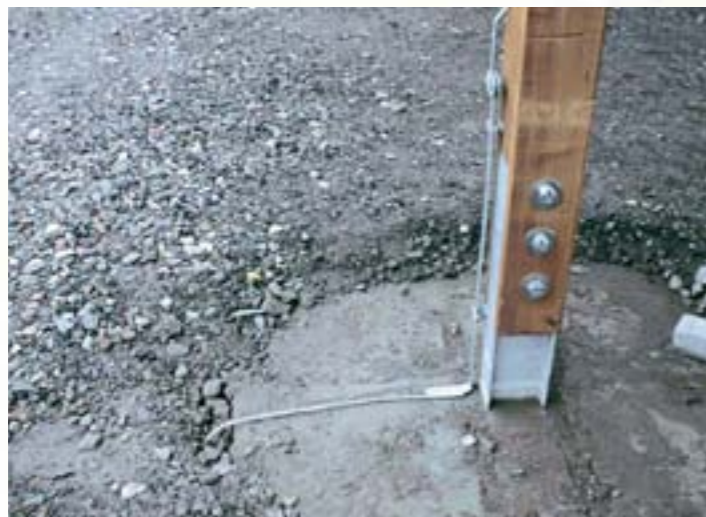
Abb. 19: Anschluss des Blitzableiter-Systems an den Ring-Erder
