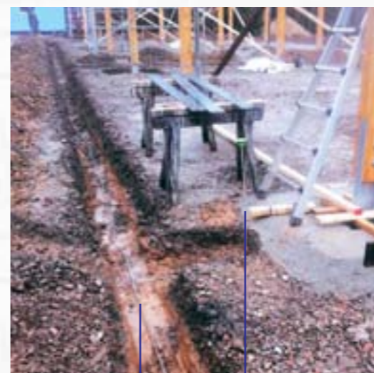
Ringerder Anschlussfahne für Fangstange
