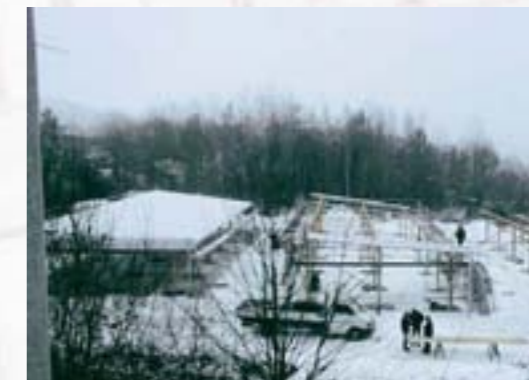
Abb. 4: Carport 1 mit Trapezblech
