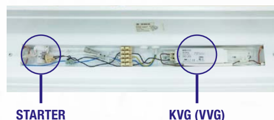
Abb. 3: Leuchtstoffröhren-Gehäuse mit konventionellem Vorschaltgerät (KVG)
