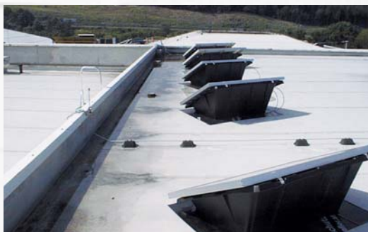
Abb. 2: Beispiel für Montage auf ConSole, Fa. Ubbink Solar
