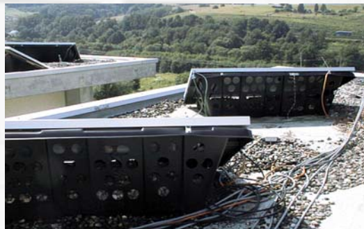
Abb. 7: Testsystem ist auf hinterlüfteten Wannen montiert
