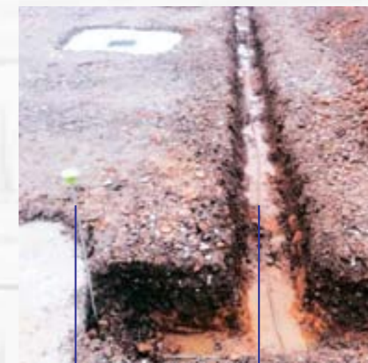
Anschlussfahne für Fangstange Ringerder
