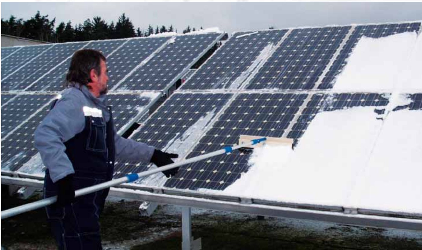
Abb. 2: Der Wartungsmitarbeiter beim Schneeräumen mit entsprechendem Räumungsgerät. Da dies einmal täglich durchgeführt wurde (sofern es zwischenzeitlich geschneit hatte), konnte es vorkommen, dass die Module kurz nach dem Freiräumen erneut zugeschneit wurden. In diesem Fall lag der Schnee bis darauffolgenden Tag. Außerdem wurde an gesetzlichen Feiertagen (z.B. Weihnachten) und an Sonntagen kein Schnee geräumt.
