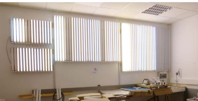
Abb. 4: Testwand für Langzeituntersuchungen (Dauertest und Zyklfestigkeit).
