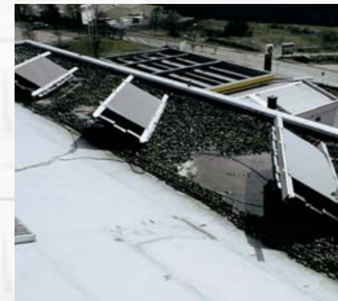
Abb. 3: Auch bei flachen Sonnenständen durften sich die Module nicht gegenseitig verschatten
