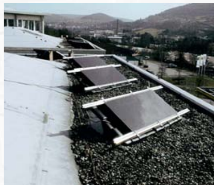
Abb. 2: Im Vordergrund: die 3 Solartechnics Module, nach Westen ausgerichtet. Im Hintergrund rechts: die nach Süden ausgerichtete Module.
